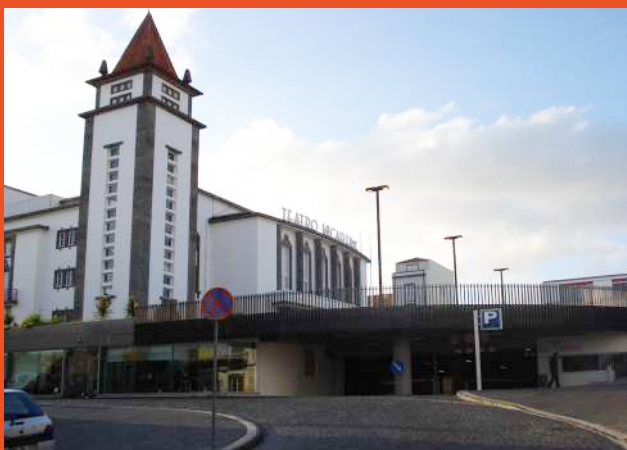
Parque de Estacionamento de São João - Região Autónoma dos Açores, Portugal / São João Car Park Lot - Autonomous Region of the Azores, Portugal
