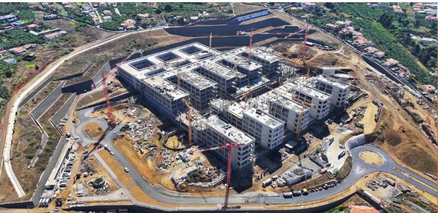
Construção do Hospital Central e Universitário da Madeira - Funchal, Região Autónoma da Madeira / Construction of the Central and University Hospital of Madeira - Funchal, Autonomous Region of Madeira
