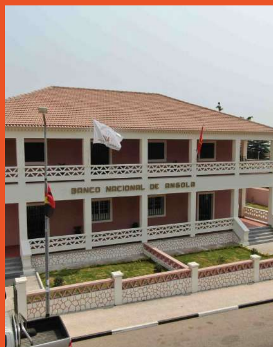
Reabilitação do Banco Nacional de Angola - Cabinda, Angola / Rehabilitation of the National Bank of Angola - Cabinda, Angola
