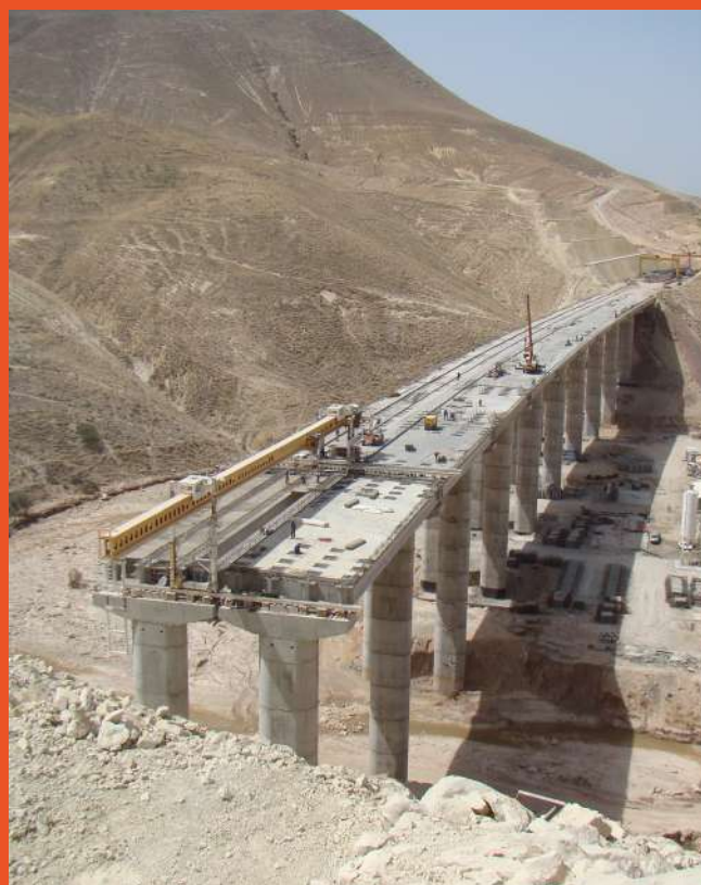
Viaduto PK9, Troço Imintanout-Argana da Autoestrada Marraxe-Agadir, Marrocos / PK9 viaduct, Imintanout-Argana section of the Marrakech-Agadir motorway, Morocco
