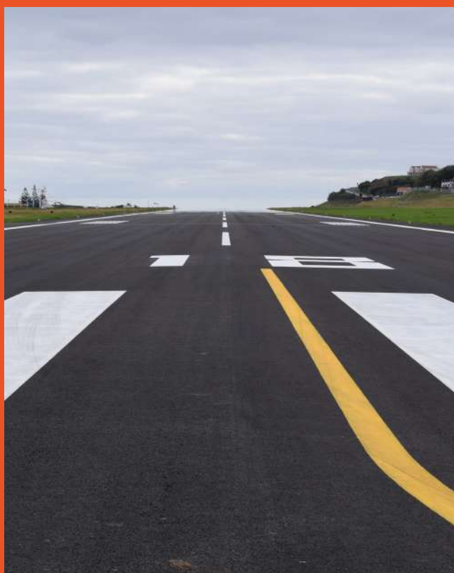
Pavimentação da Pista do Aeroporto das Flores - Flores, Região Autónoma dos Açores / Paving of the Flores Airport - Flores, Autonomous Region of the Azores
