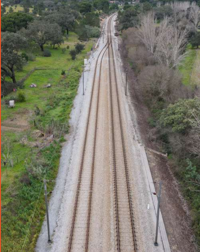
Modernização do Troço Ferroviário Ermidas do Sado - Grândola Norte, Portugal / Modernisation of the Ermidas do Sado Railway Section - Grândola Norte, Portugal
