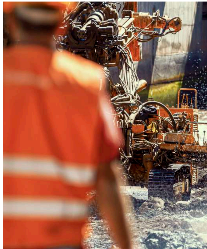
Trabalhos de geotecnia na Requalificação Ribeira Santa Luzia - Funchal, Região Autónoma da Madeira Geotechnical works in the Requalification of Santa Luzia Stream - Funchal, Autonomous Region of Madeira
