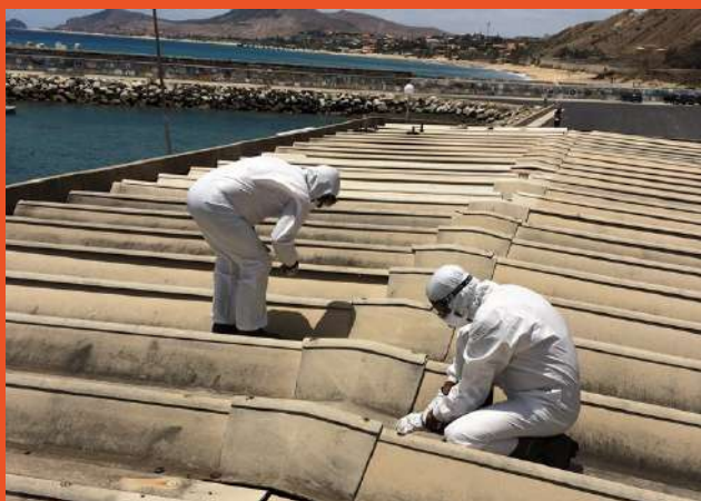
Remoção Telhas com Amianto em Escola - Flores, Região Autónoma dos Açores / Removal of Asbestos Roof Tiles in a School - Flores, Autonomous Region of the Azores
