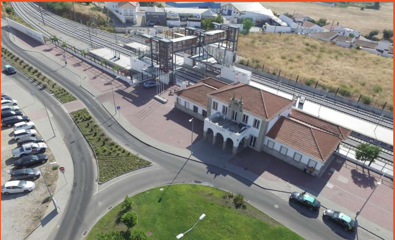
Modernização da Estação de Évora - Portugal / Modernisation of Évora Train Station - Portugal
