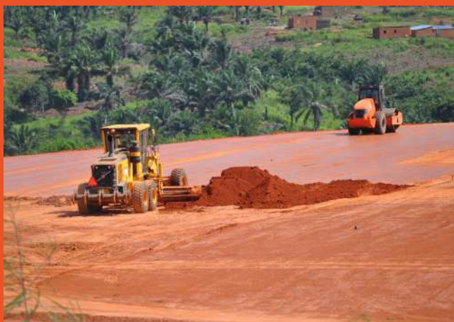
Ampliação da pista do Aeroporto do Dundo - Lunda Norte, Angola / Expansion of the runway at Dundo Airport - Lunda Norte, Angola
