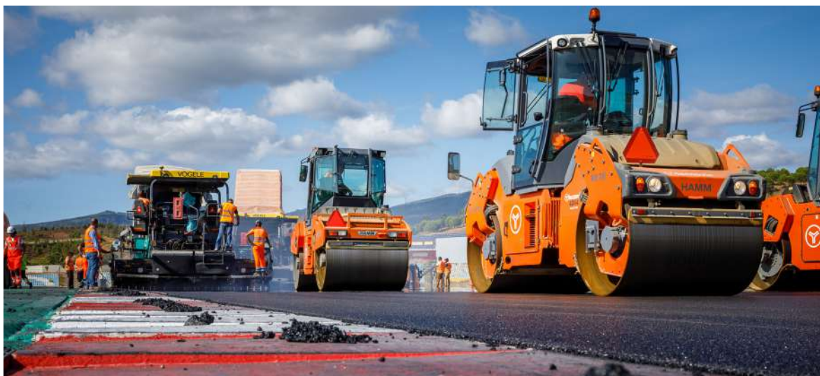
Pavimentação da camada de desgaste do Autódromo Internacional do Algarve para o GP de Fórmula 1 - Portimão, Portugal / Asphalt paving of Algarve International Racetrack for the Formula 1 GP - Portimão, Portugal
