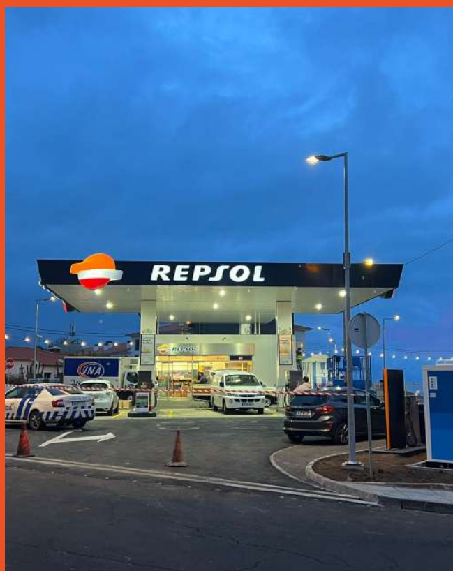
Posto de Abastecimento - Cancela, Região Autónoma da Madeira / Fuel Station - Cancela, Autonomous Region of Madeira
