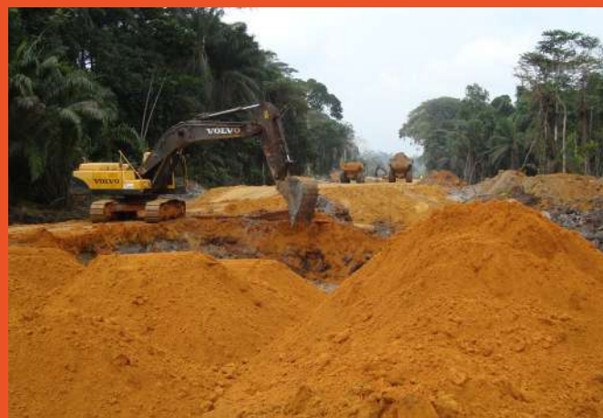
Construção Estrada na Província de Cabinda, Angola / Road construction in Cabinda Province, Angola
