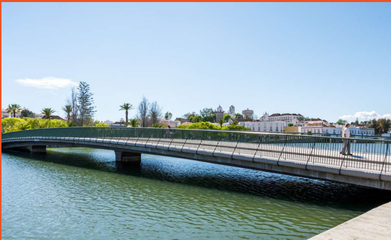
Ponte sobre o Rio Gilão - Tavira, Portugal / Bridge over the River Gilão - Tavira, Portugal
