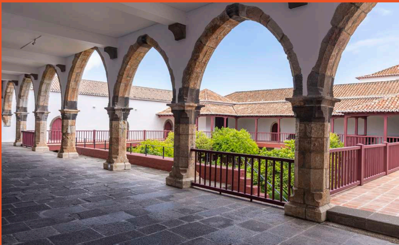
Requalificação Convento de Santa Clara - Funchal, Região Autónoma da Madeira (Menção Honrosa de Melhor Intervenção de Restauro do Prémio Nacional de Reabilitação Urbana 2023) / Requalification of the Santa Clara Convent - Funchal, Autonomous Region of Madeira (Honourable Mention for Best Restoration Intervention in the National Urban Rehabilitation Prize 2023)
