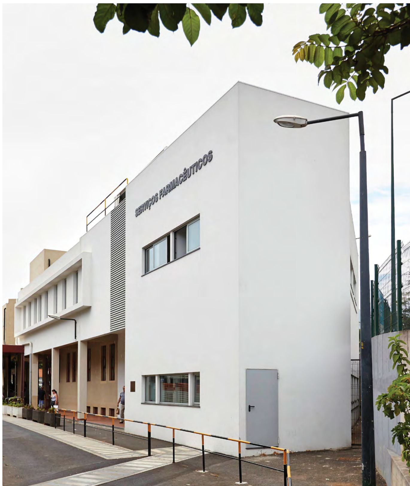
Obra de Remodelação e Ampliação da Farmácia do Hospital Dr. Nélcio Mendonça.
