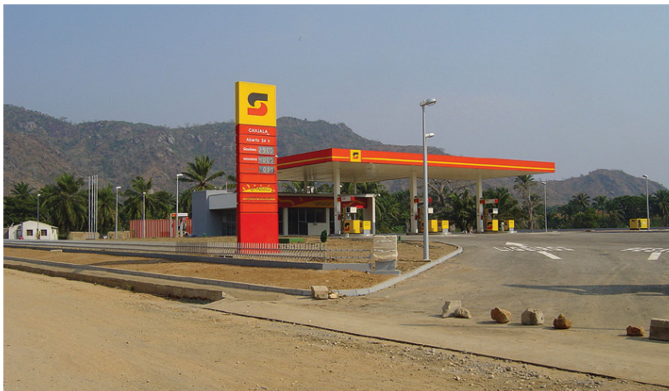
Posto de Combustível da Sonangol de Canjala, Benguela. Cliente: Sonangol Distribuidora. Station de carburante Sonangol de Canjala, Benguela. Client: Sonangol Distribuidora. Sonangol Fuel Station of Canjala, Benguela. Client: Sonangol Distribuidora.
