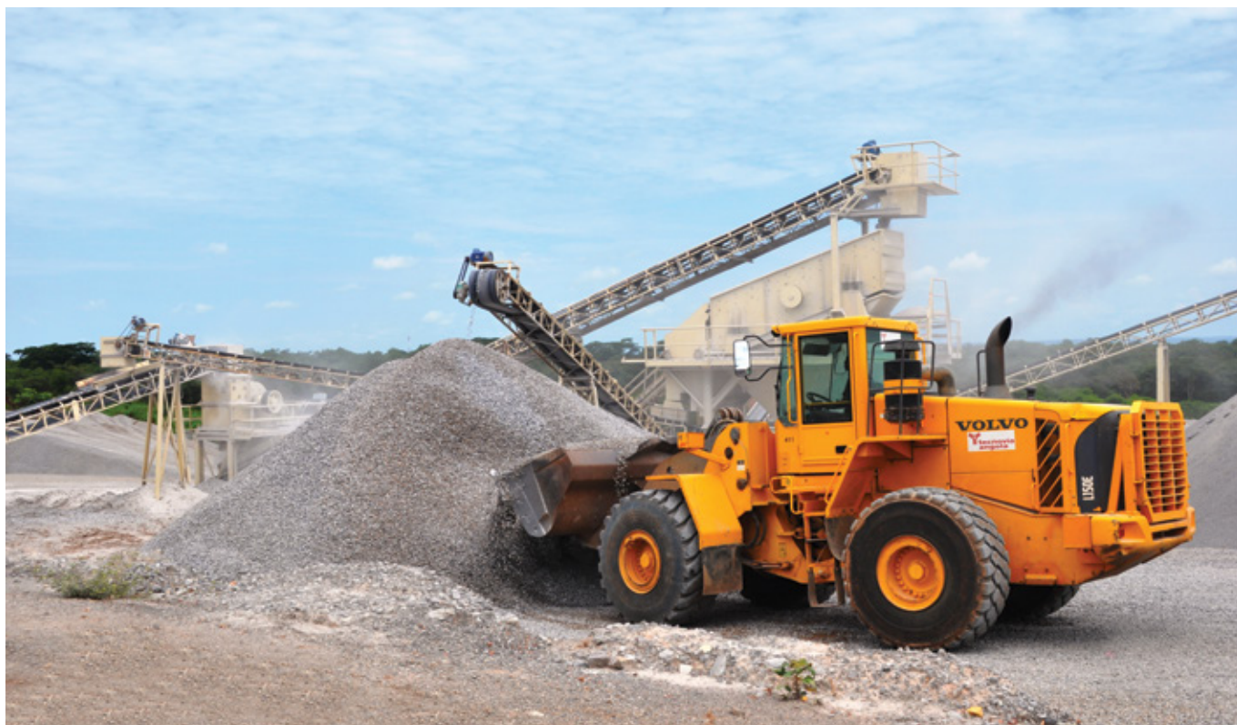
Centro Industrial de Malanje – Central de Britagem, Malanje. Centre Industriel de Malanje – Central de Broyage, à Malanje. Malanje Industrial Center – Crushing Plant, Malanje.
