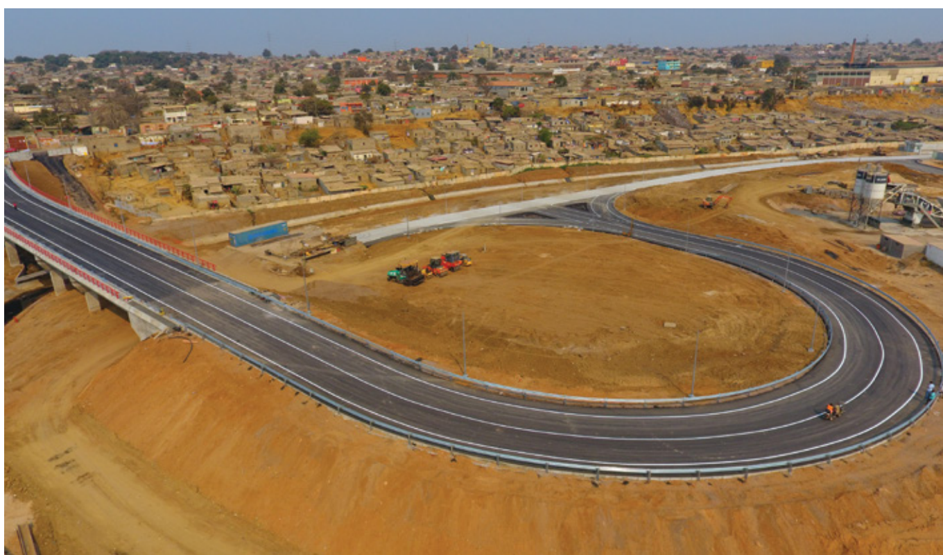
Construção de acesso à zona portuária e industrial da Pumangol e execução de canal de drenagem, Luanda. Cliente: Pumangol Industrial LDA. Construction d'accès à la zone portuaire et industrielle de Pumangol et exécution du canal de drainage, Luanda. Client: Pumangol Industrial LDA. Construction of access to the port and industrial area of Pumangol and construction of drainage channel, Luanda. Client: Pumangol Industrial LDA.
