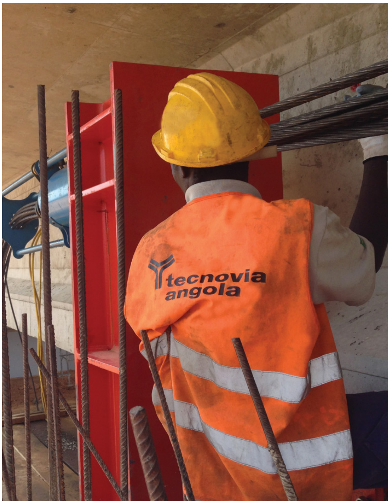
Operações de lançamento do tabuleiro, Ponte sobre o Rio Cuito, Cuito Cuanavale, Cuando-Cubango. Cliente: Ministério da Construção. Opérations de lancement du plateau, Pont sur le Fleuve Cuito, Cuito Cuanavale, Cuando-Cubango. Client: Ministère de la Construction. Slab installation, Bridge over the Cuito River, Cuito Cuanavale, Cuando-Cubango. Client: Ministry of Construction.
