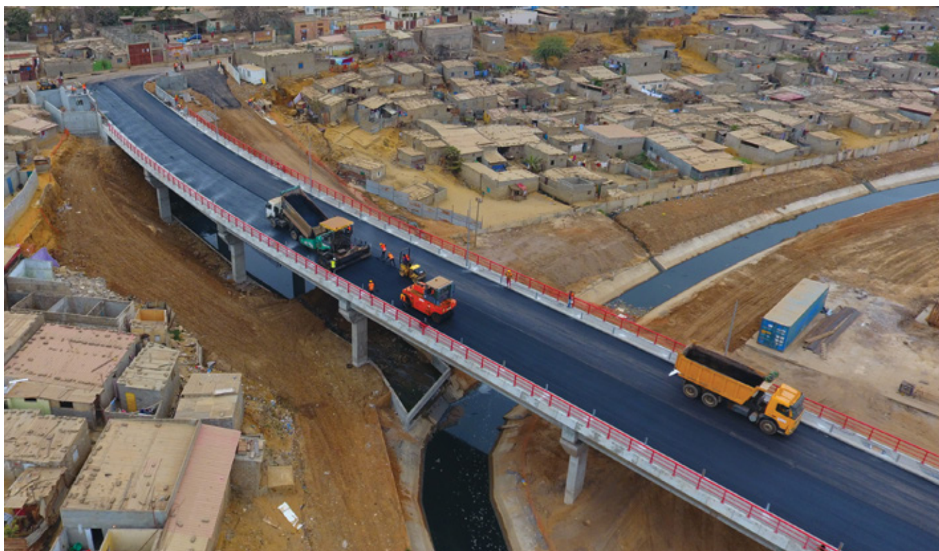
Pavimentação do viaduto de acesso à Pumangol, Luanda, Angola. Cliente: Pumangol Industrial LDA. Pavage du viaduc d'accès à Pumangol, Luanda, Angola. Client: Pumangol Industrial LDA. Paving of the Pumangol access viaduct, Luanda, Angola. Client: Pumangol Industrial LDA.
