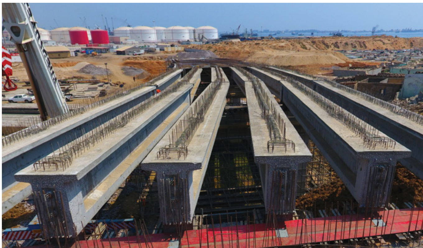
Pré-fabricação de vigas em betão armado e pré-esforçado, Luanda. Pré-fabrication de poutres en béton renforcé et précontraint, Luanda. Prefabrication of reinforced and pre-stressed concrete beams, Luanda.
