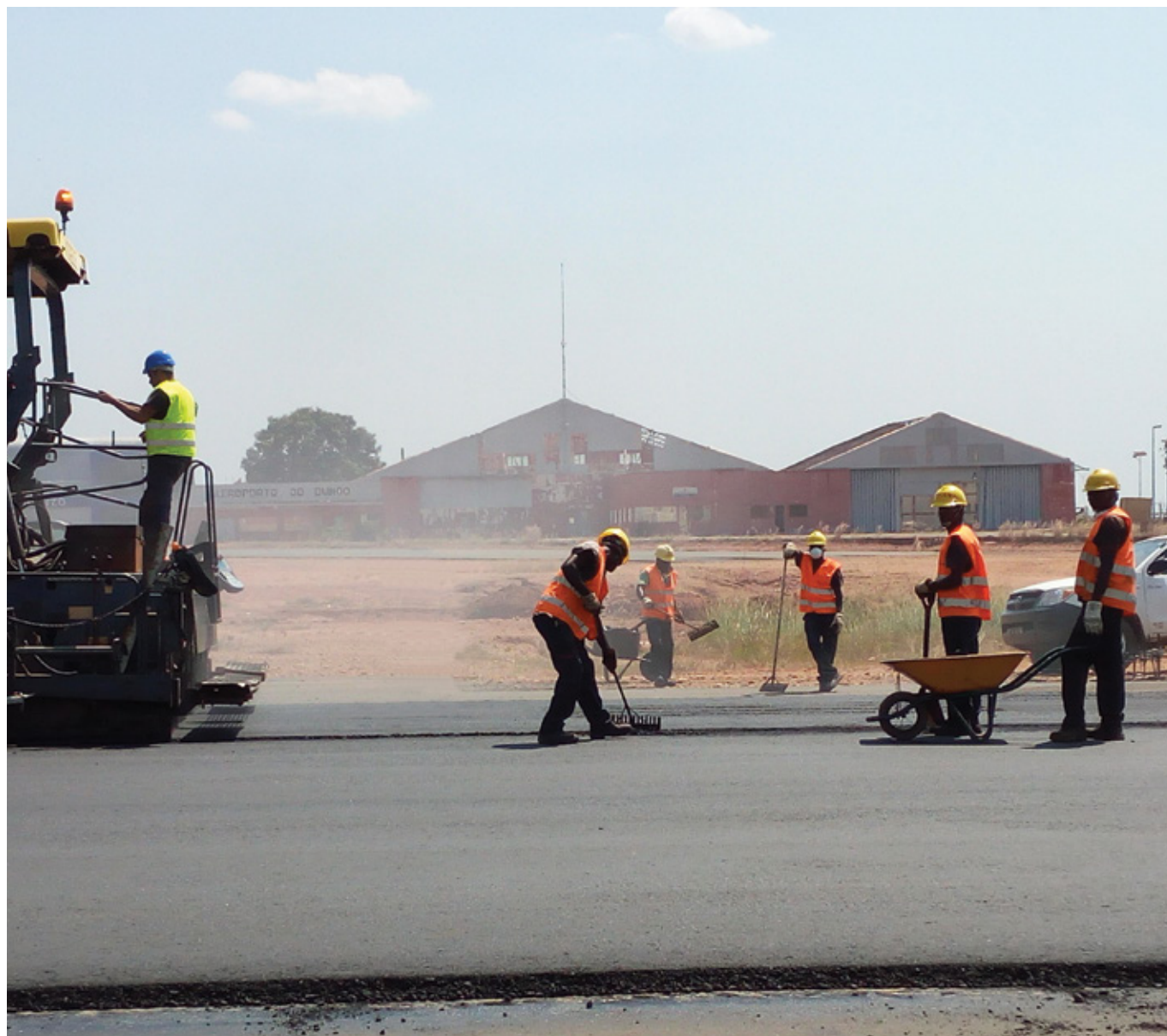
Pavimentação da Pista do Aeroporto Kamakenzo, Dundo, Lunda Norte. Pavage de la Piste de l'Aérodrome Kamakenzo, Dundo, Luanda Norte. Paving of the Kamakenzo airport runway, Dundo, Luanda Norte.
