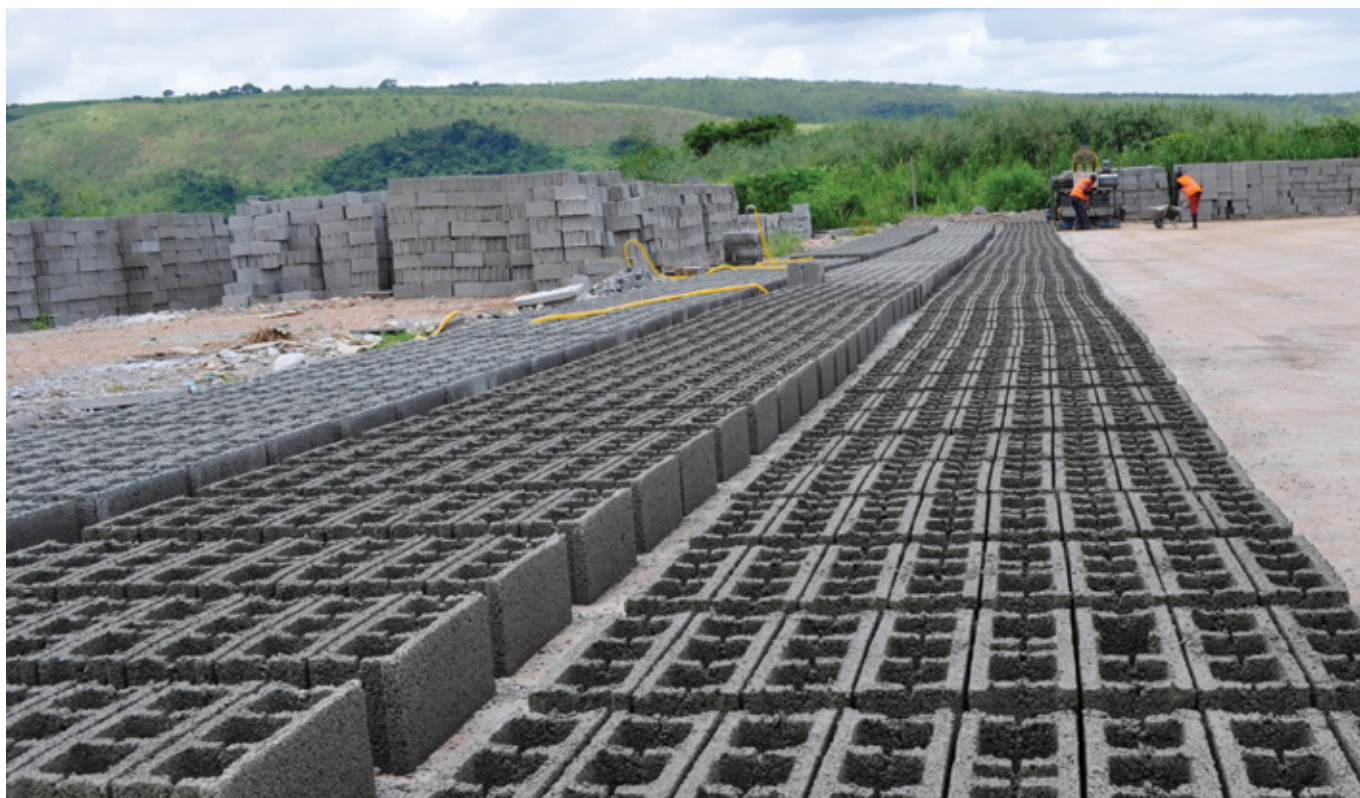
Estaleiro de Nôqui – Produção de Pré-fabricados em betão, Zaire. Chantier de Nôqui – Production de Préfabriqués en béton, Zaire. Nôqui Construction Site – Production of Precast concrete, Zaire.
