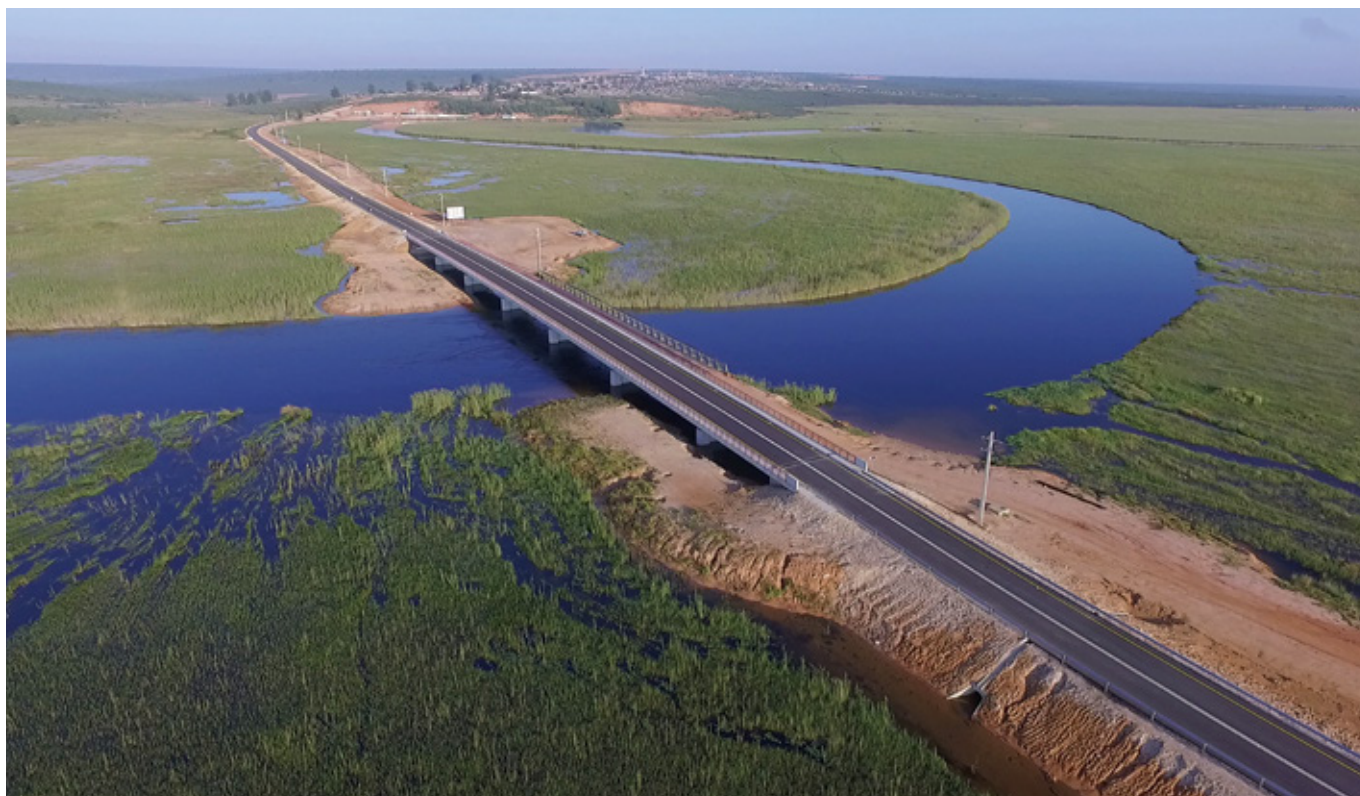
Ponte sobre o Rio Cuito e acessos rodoviários, Cuito Cuanavale, Cuando Cubango. Cliente: Ministério da Construção. Pont sur le Fleuve Cuito et accès routier, Cuito Cuanavale, Cuando Cubango. Client: Ministère de la Construction. Bridge over the Cuito River and access road, Cuito Cuanavale, Cuando Cubango. Client: Ministry of Construction.
