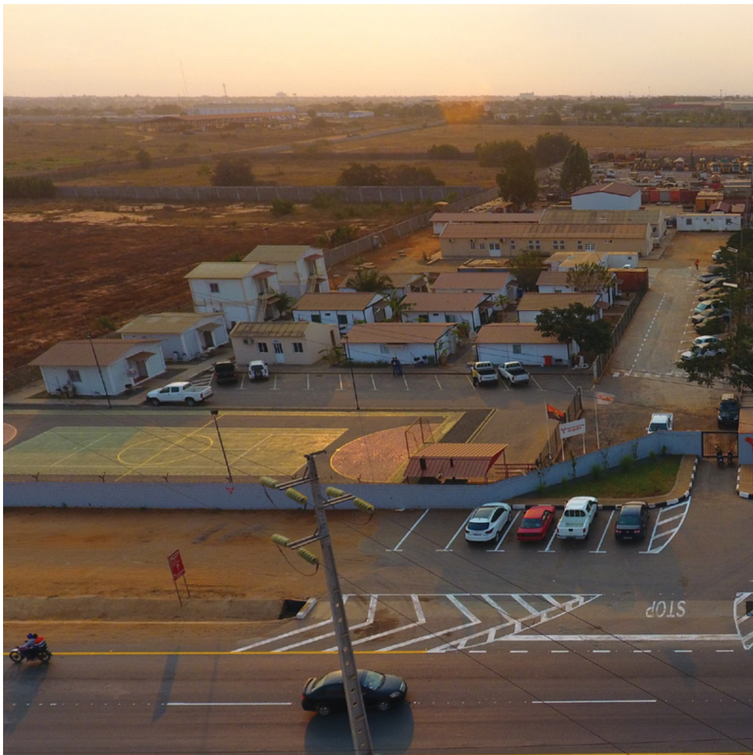
Estaleiro Central da Tecnovia Angola, Viana, Luanda. Chantier Central de Tecnovia Angola, Viana, Luanda. Central Construction Site of Tecnovia Angola, Viana, Luanda.
