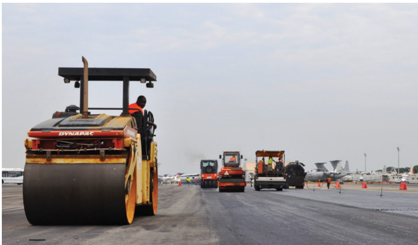
Reforço e reperfilamento da placa de estacionamento de aeronaves do Aeroporto 4 de Fevereiro, Luanda. Cliente: ENANA, E.P. – Ministério dos Transportes. Renforcement et reprofilage du tarmac de l'Aéroport 4 de Fevereiro, Luanda. Client: ENANA, E.P. – Ministère des Transports. Strengthening and reprofiling of the aircraft parking apron of the 4 de Fevereiro Airport. Client: ENANA, E.P. – Ministry of Transport.
