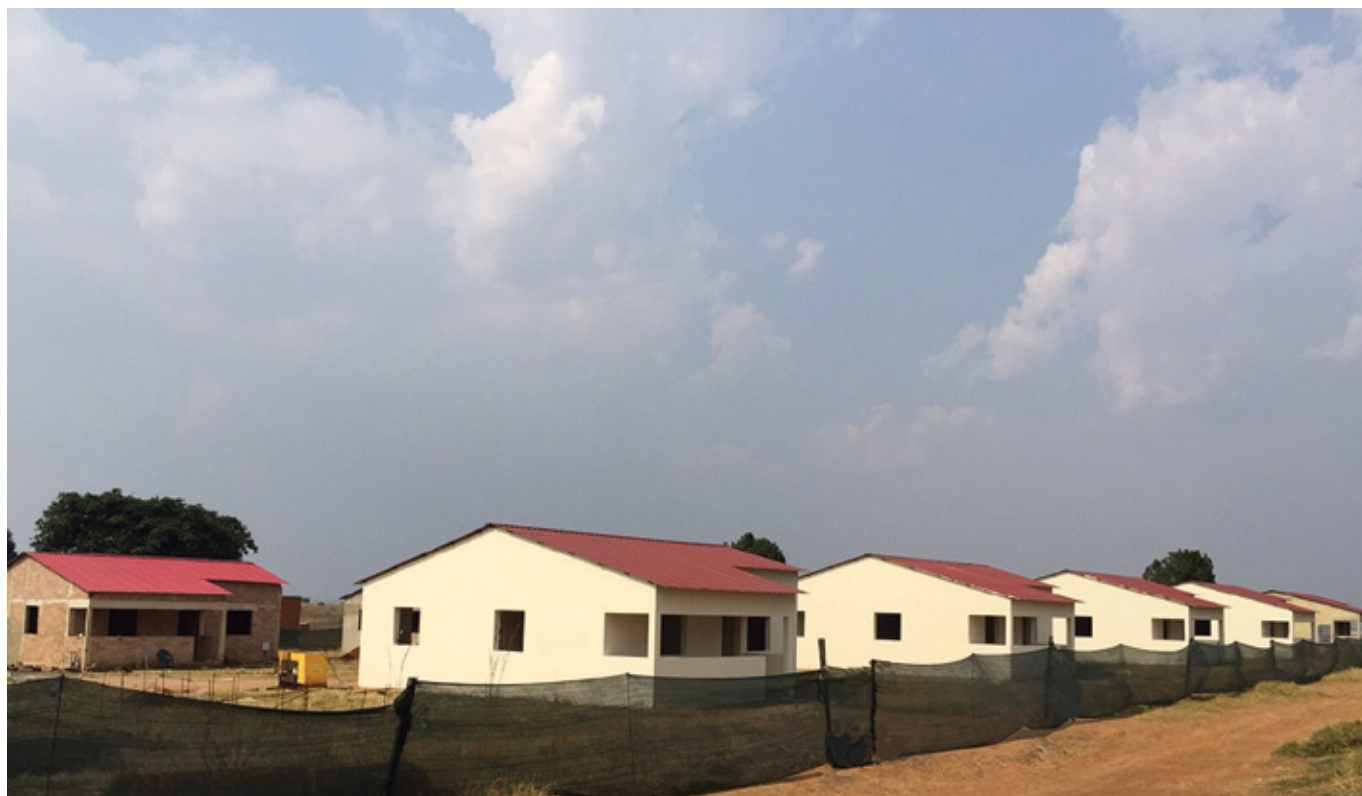
Construção de 10 moradias T3 no Município de Chinguar, Bié. Cliente: Governo Provincial do Bié. Construction de 10 demeures T3 à la municipalité de Chinguar, Bié. Client: Gouvernement Provincial du Bié. Construction of 210 3-room houses in the municipality of Chinguar, Bié. Client: Provincial Government of Bié.
