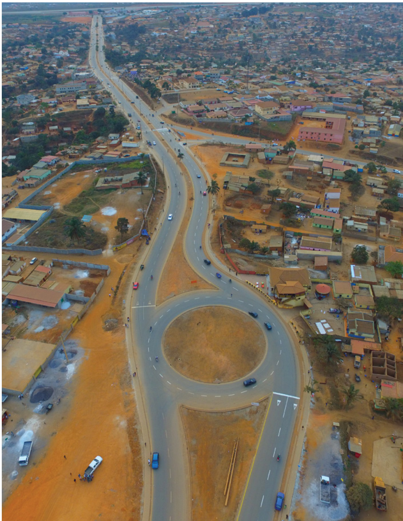
Reabilitação da estrada de acesso ao Aeroporto Manuel Quarta Punza, Uíge. Cliente: Governo Provincial do Uíge.
