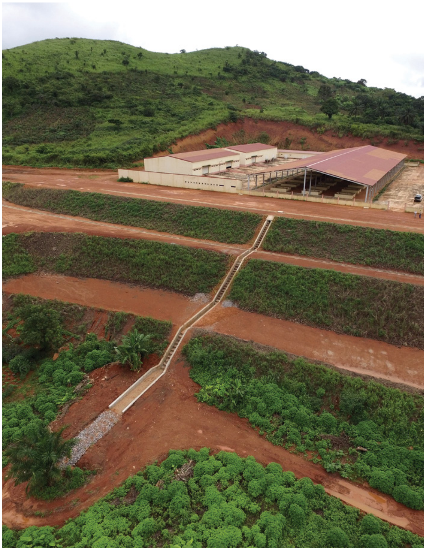
Contenção de taludes, recuperação da área degradada e drenagem do Mercado N'Dalatando, Cuanza Norte. Cliente: Ministério da Construção. Retenue de talus, récupération de la zone dégradée et drainage du Marché N'Dalatando, Cuanza Norte. Client: Ministère de la Construction. Slope Contention, recovery of the degraded area and drainage of the N'Dalatando Market, Cuanza Norte. Client: Ministry of Construction.
