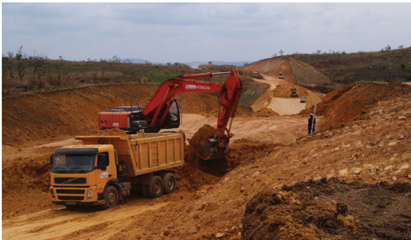
Estrada M'Banza Congo, Luvo, Nóqui (170 Km), Zaire. Cliente: INEA – Ministério da Construção. Route M'Banza Congo, Luvo, Nóqui (170 Km), Zaire. Client: INEA – Ministère de la Construction. M'Banza Congo road, Luvo, Nóqui (170 Km), Zaire. Client: INEA – Ministry of Construction.
