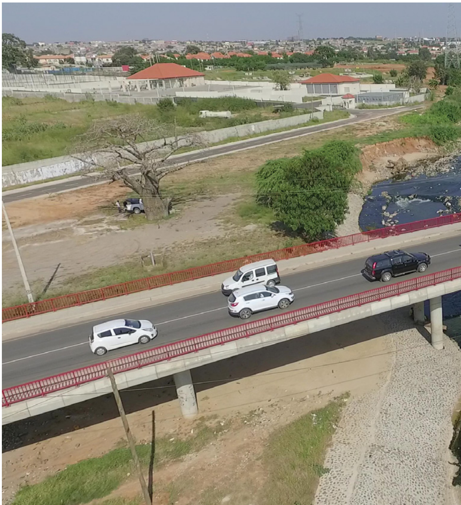
Ponte sobre o Rio Cambamba, antiga "Ponte Molhada", Luanda. Cliente: Ministério da Construção. Pont sur le Fleuve Cambamba, ancienne "Ponte Molhada", Luanda. Cliente: Ministério da Construção. Bridge over the Cambamba River, former "Ponte Molhada" bridge, Luanda. Cliente: Ministério da Construção.
