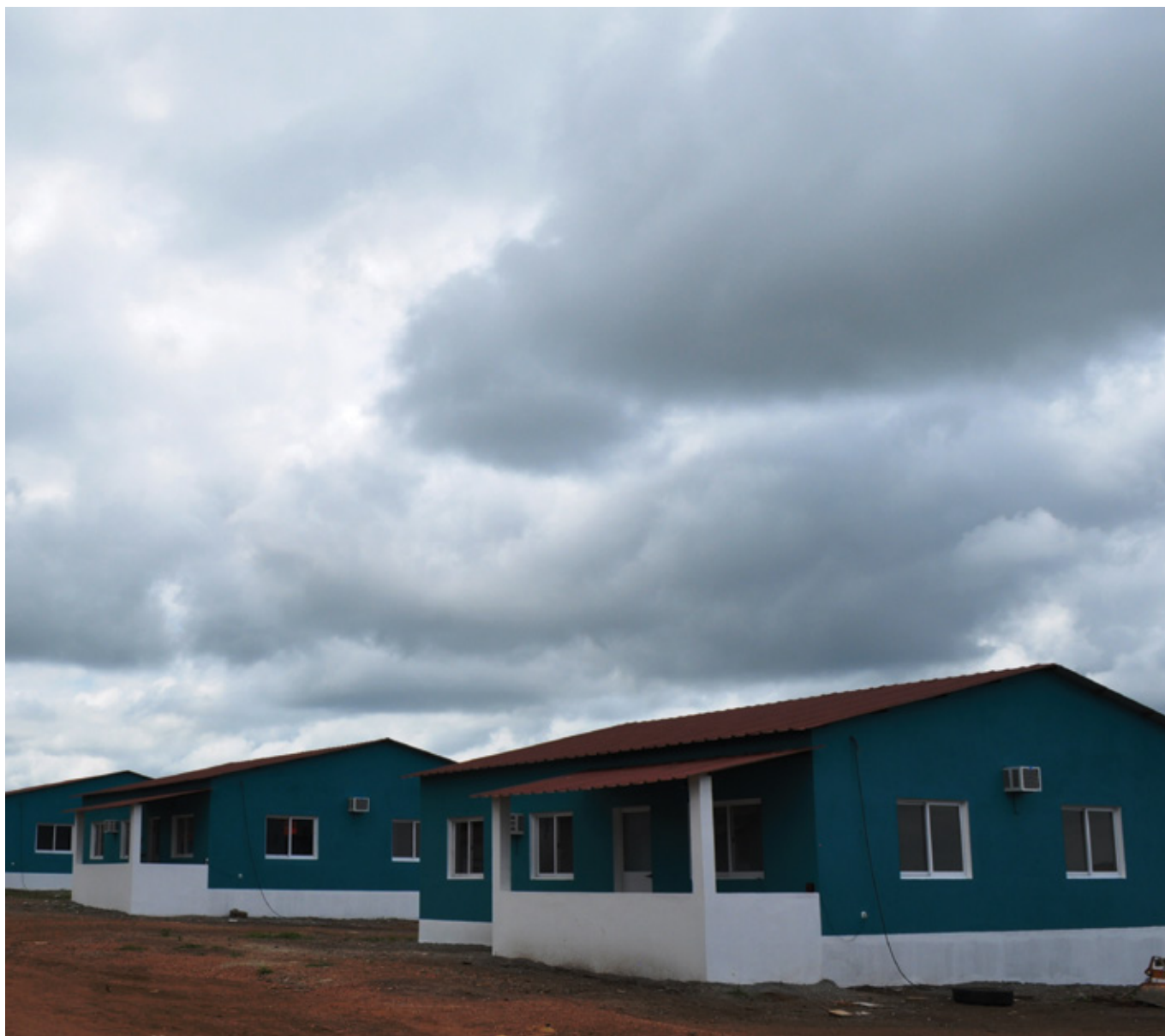
Construção de 200 moradias T3 no Município do Nóqui, Zaire. Cliente: Governo Provincial do Zaire. Construction de 200 demeures T3 à la municipalité de Nóqui, Zaire. Client: Gouvernement Provincial du Zaire. Construction of 200 3-room houses in the municipality of Nóqui, Zaire. Client: Provincial Government of Zaire.
