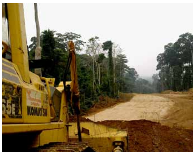
Construção da Estrada Buco Zau Necuto, Angola
