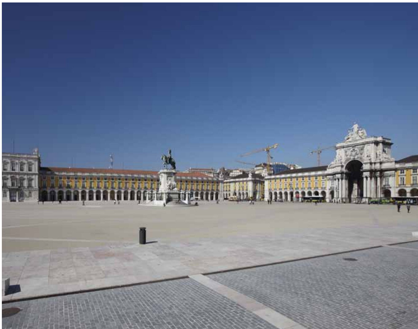
Empreitada de Construção da Placa Central do Terreiro do Paço Lisboa, Portugal
