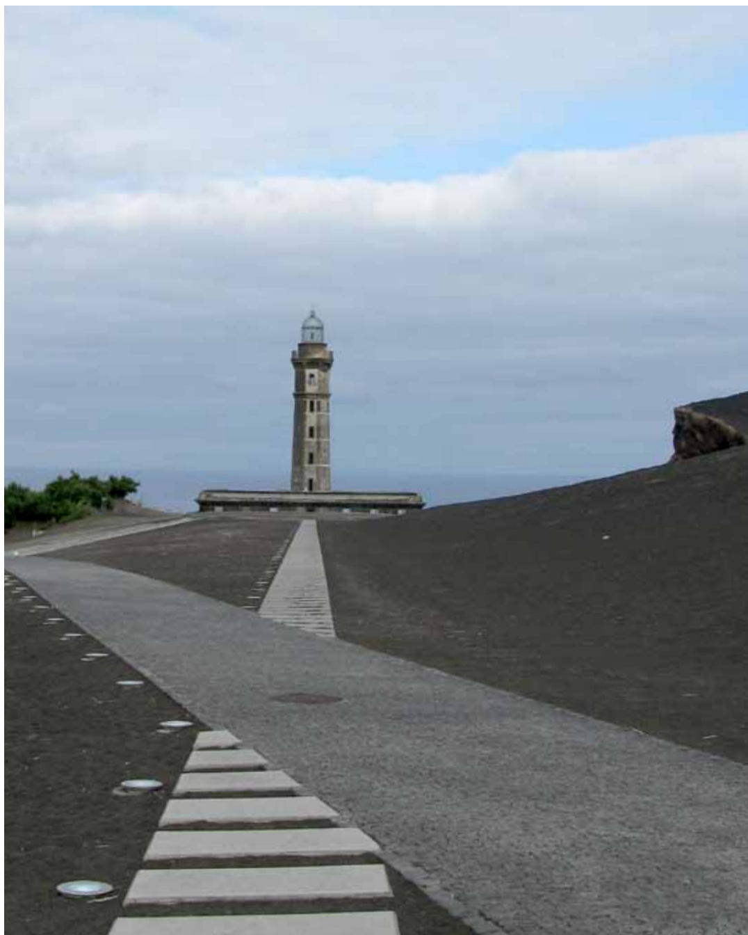
Construção do Acesso ao Vulcão dos Capelinhos Ilha do Faial - Açores, Portugal
