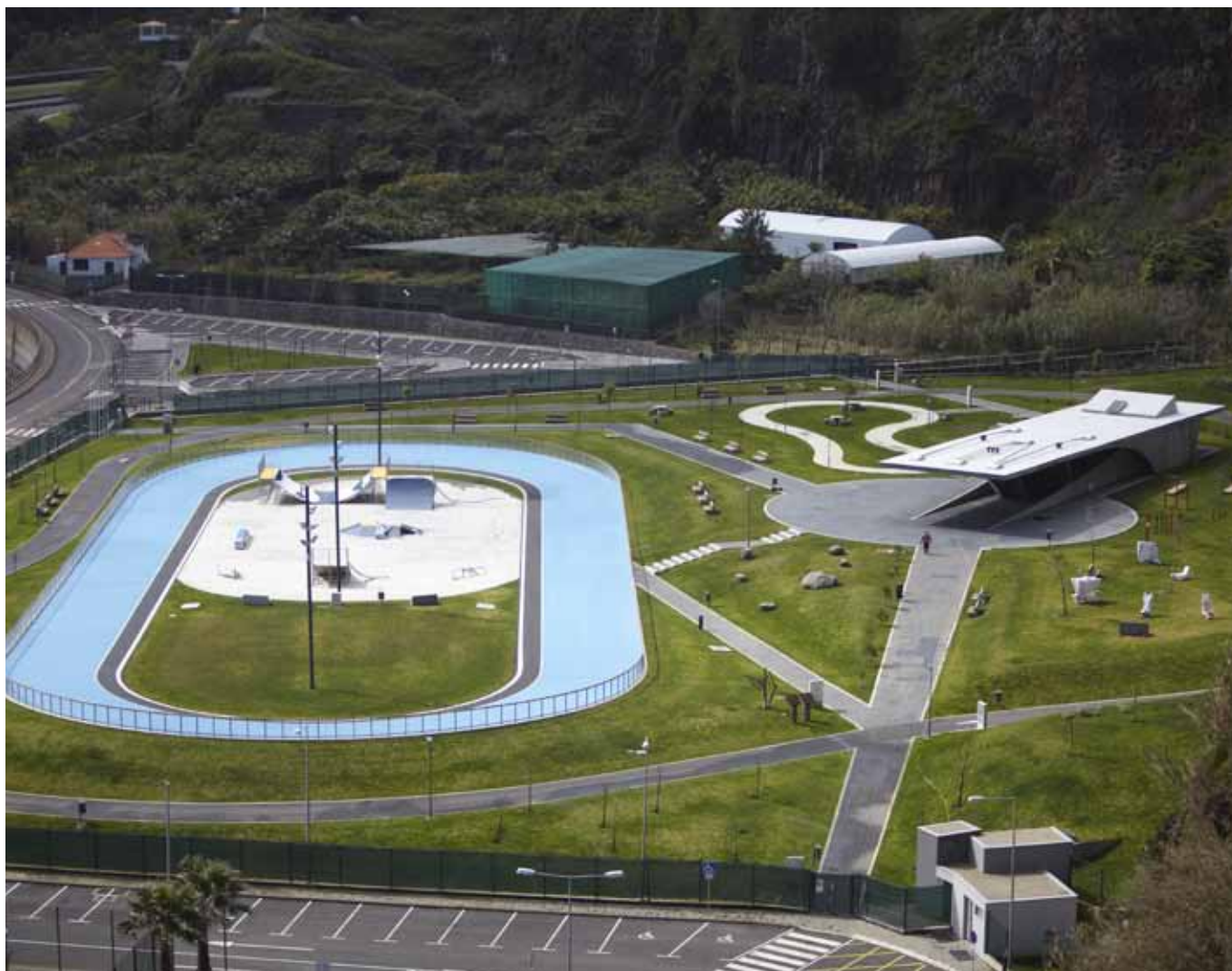
Construção da Zona de Lazer da Foz da Ribeira do Faial Ilha da Madeira, Portugal
