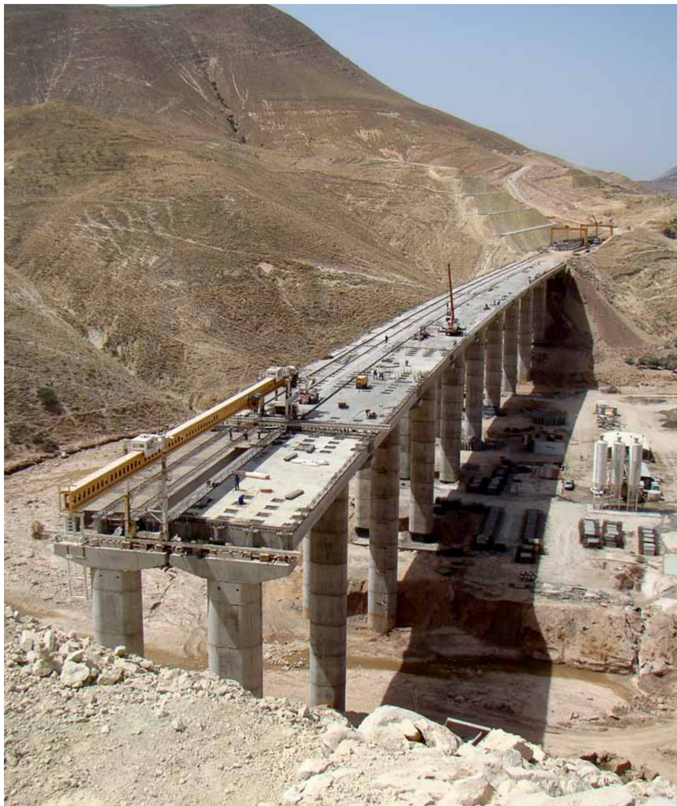
Viaduto sobre o Oued Amzeness Marrocos
