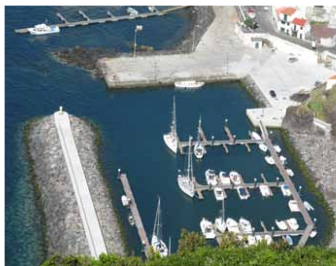
Construção da Marina das Velas Ilha de São Jorge - Açores, Portugal
