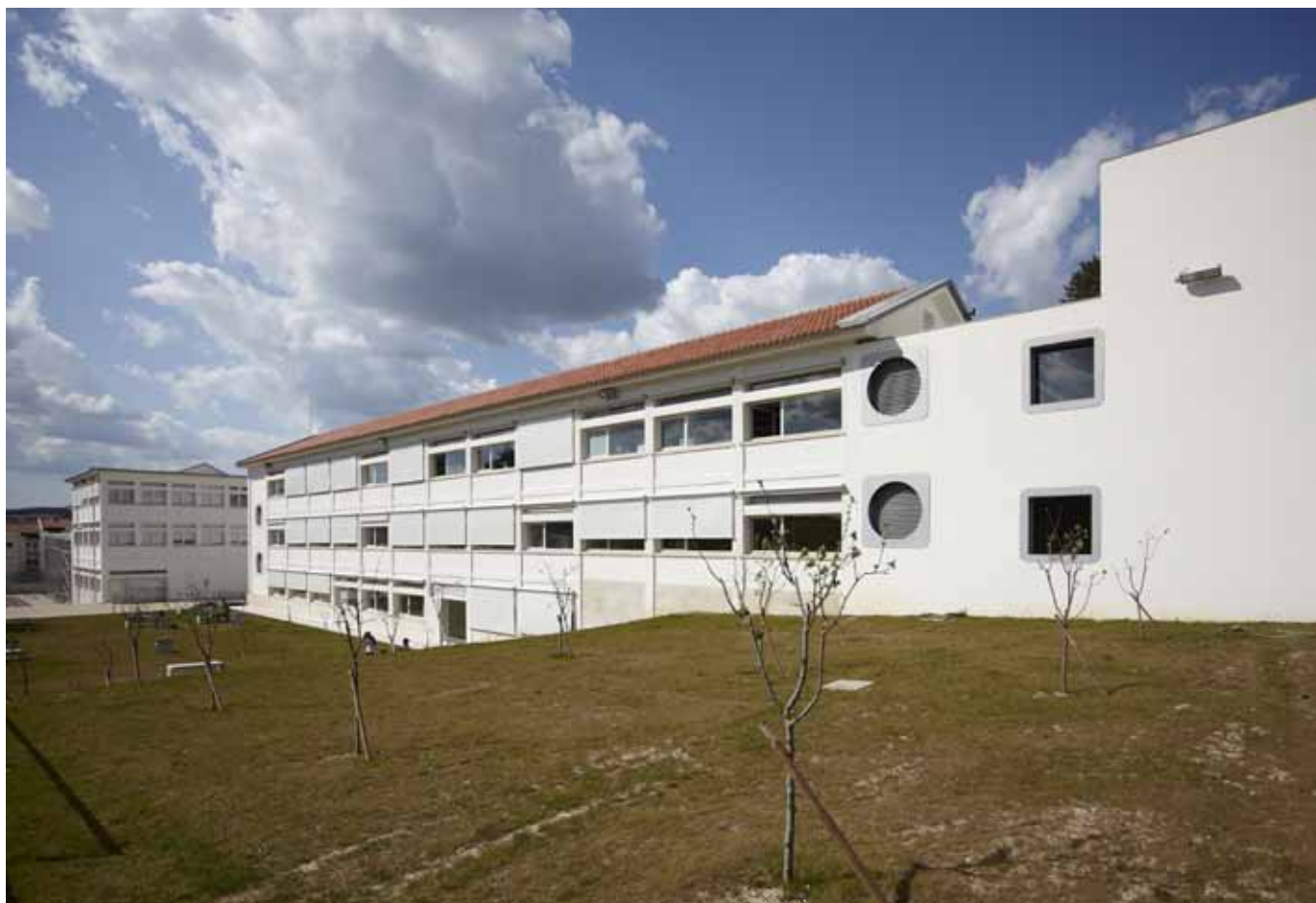
Empreitada de Execução das Obras de Modernização das Escolas com Ensino Secundário - Escola Rodrigues Lobo Leiria, Portugal
