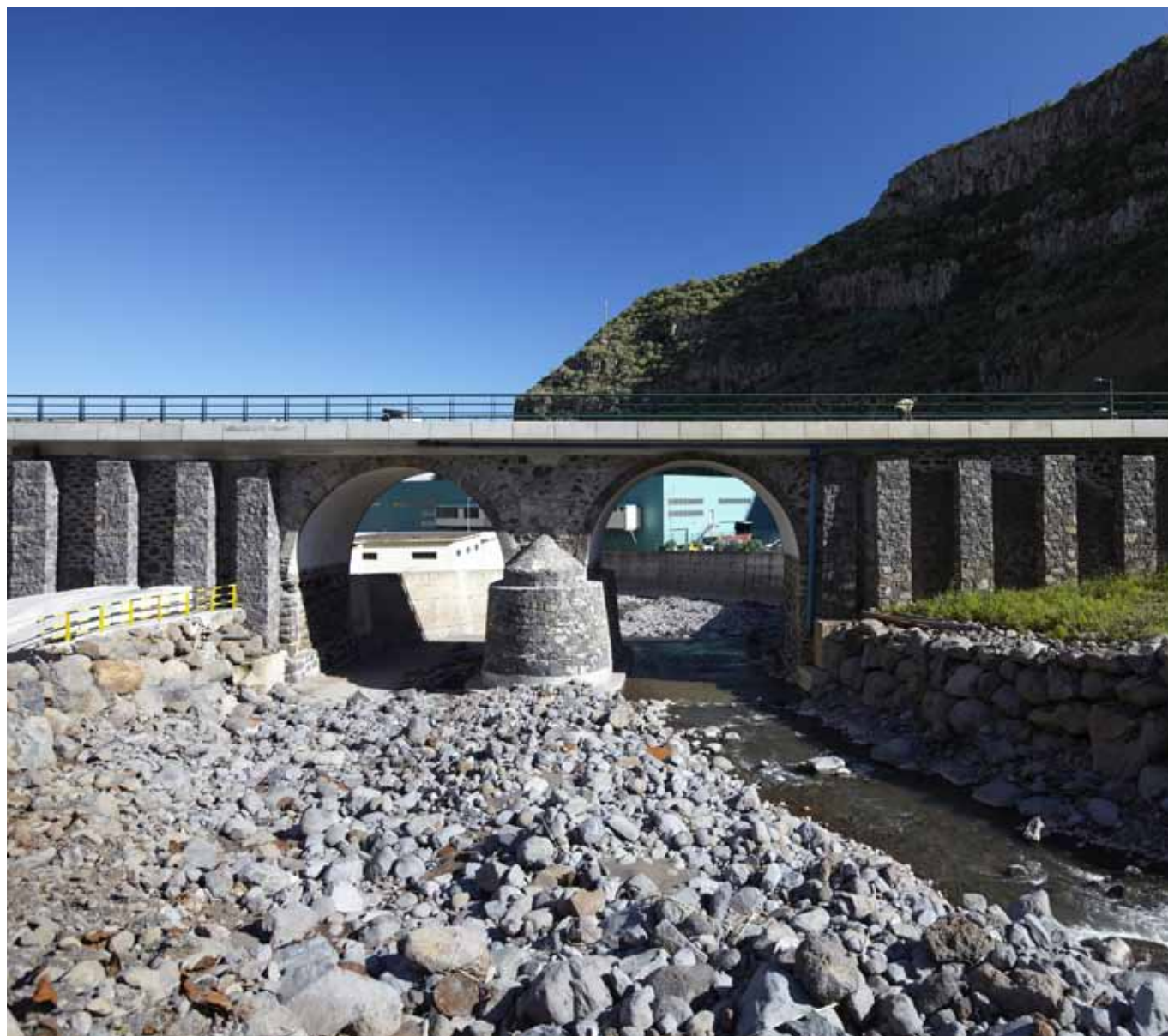
Reabilitação da Antiga Ponte sobre a Ribeira do Porto Novo Ilha da Madeira, Portugal
