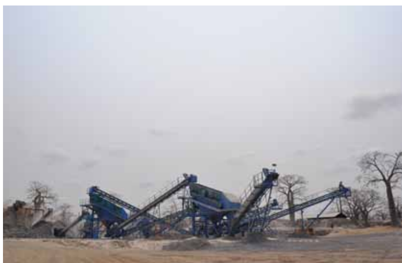
Central de Britagem do Caxito Angola
