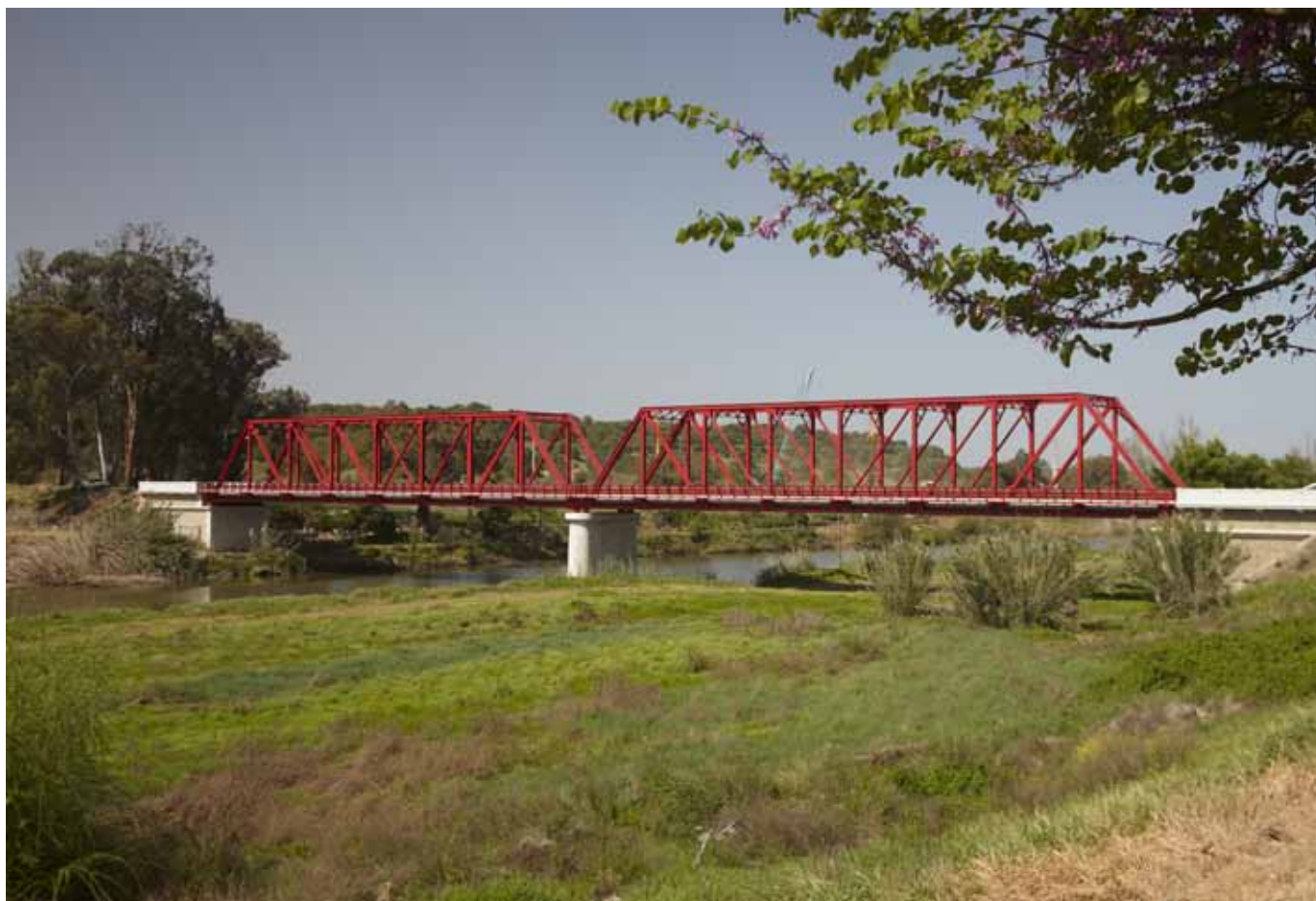
Reabilitação da Ponte de Santa Margarida do Sado Portugal
