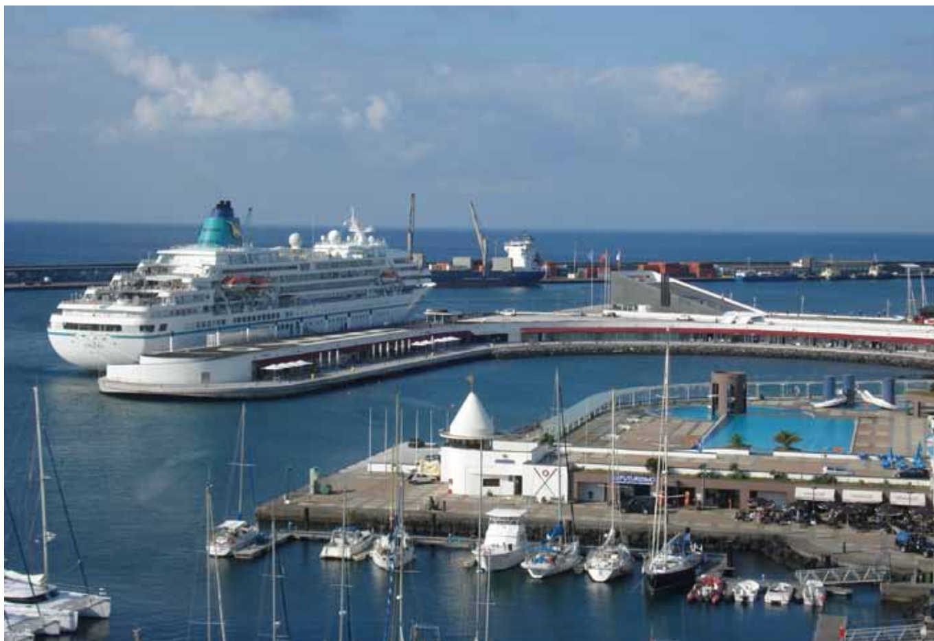
Construção do Terminal Marítimo de Cruzeiros de Ponta Delgada Ilha de São Miguel - Açores, Portugal
