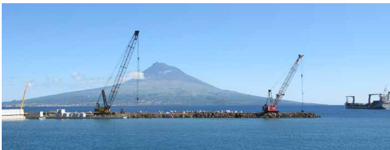
Construção do Porto de Cruzeiros da Horta Ilha do Faial - Açores, Portugal
