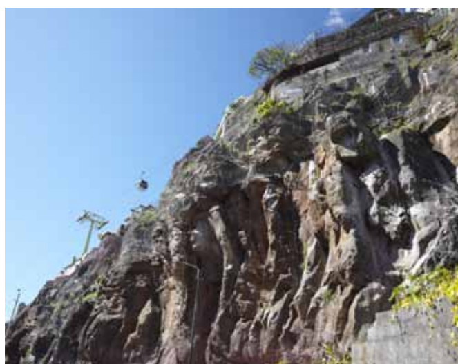
Consolidação da Escarpa Rochosa da Pena Ilha da Madeira, Portugal
