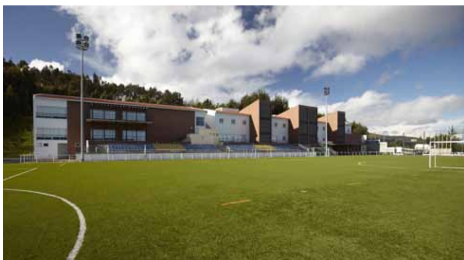
Complexo Desportivo da Associação de Futebol da Madeira Ilha da Madeira, Portugal
