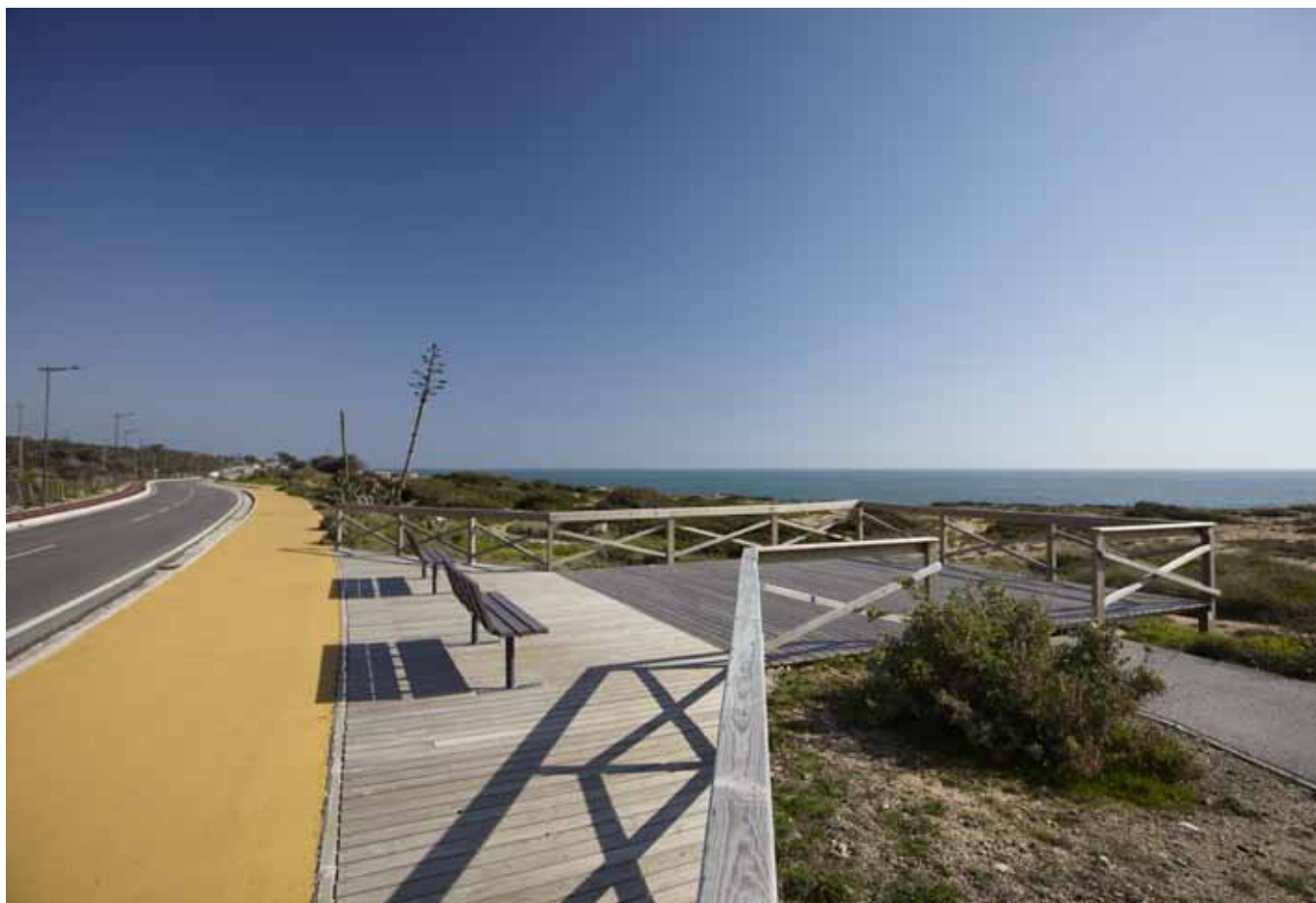
Concepção e construção do Passeio Pedonal Guia Guincho, Portugal
