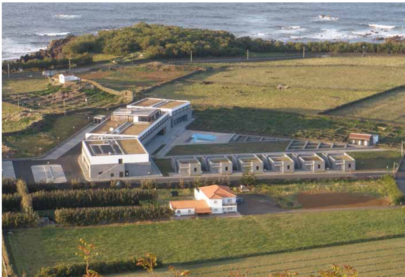
Construção do Hotel da Graciosa Ilha da Graciosa - Açores, Portugal
