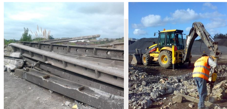
Triagem e demolição de RCD para valorização (produção de agregados reciclados), Centro de Valorização, Ilha de São Miguel, Açores, Portugal.
