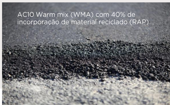
Misturas betuminosas recuperadas (RAP)
